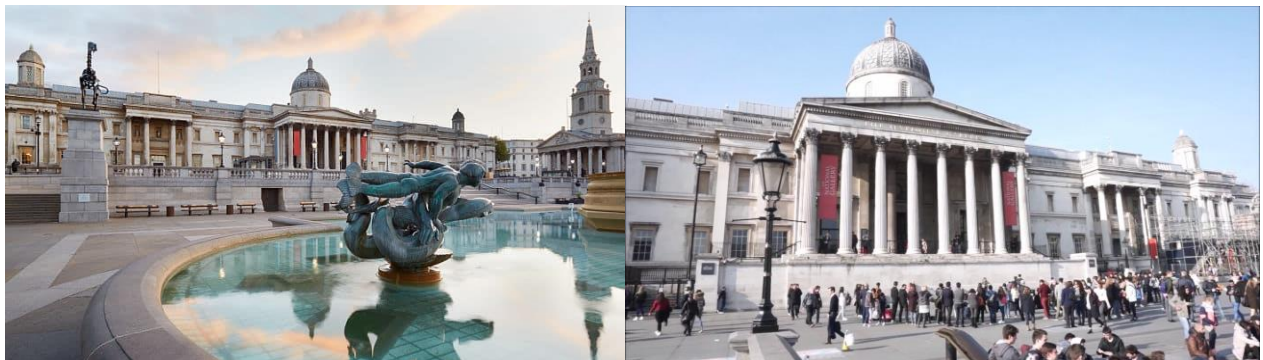
Imágenes 31 y 32 – Fachada de la Galería Nacional de Arte de Londres.
