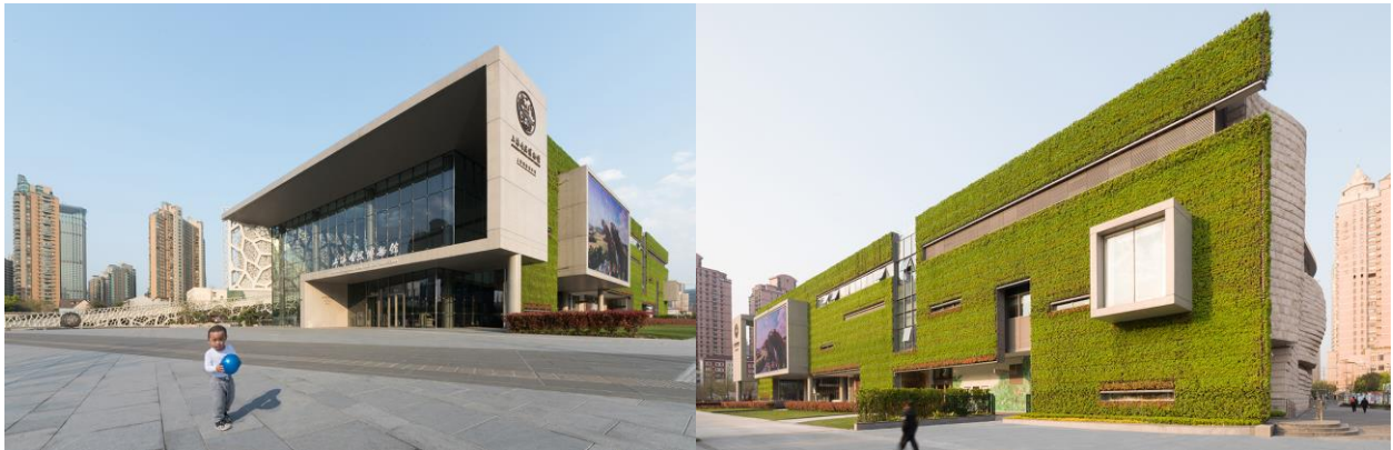
Imágenes 60 y 61 – Vistas exteriores de las fachadas de ingreso y lateral.
