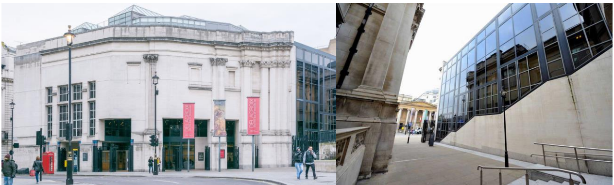
Imágenes 33 y 34 – Ampliación Sainsbury Wing de la Galería Nacional de Arte de Londres.
