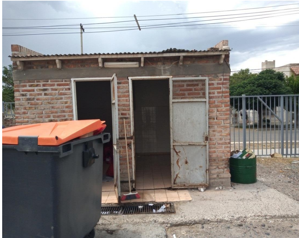
Gral Roca – almacenamiento final de RBP 2
